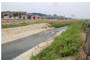
●2011年6月16日 改修後の男堀川の落差
